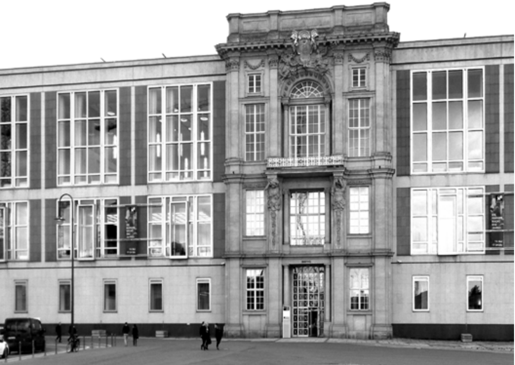
Abb. 4: Berlin, ehem. Staatsratsgebäude (1962/64) mit wiederverwendeten Teilen des sog. Liebknechtportals des Stadtschlusses
