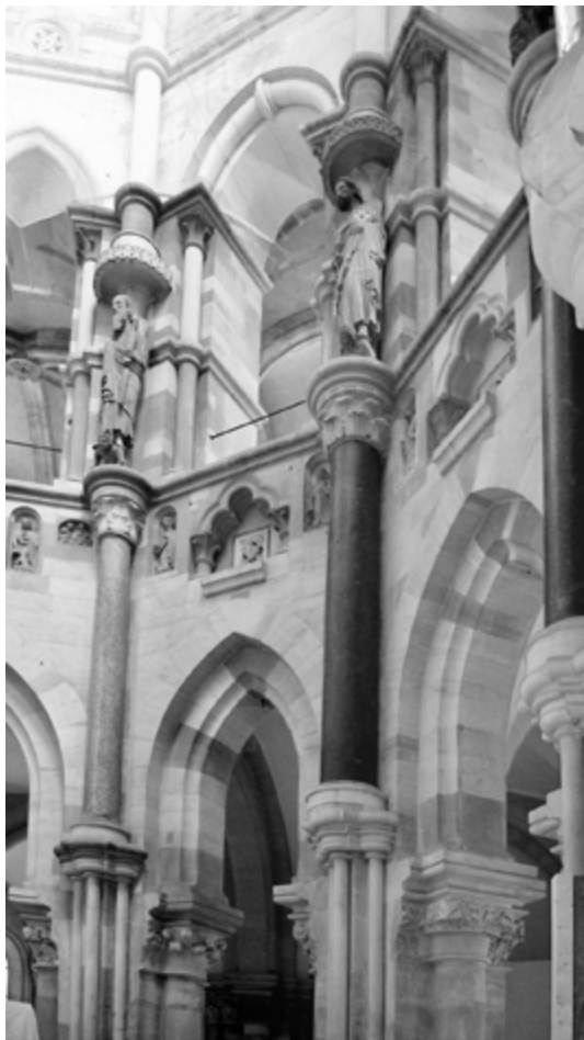
Abb. 3: Magdeburg, Domchor (nach 1209), aus dem ottonischen Vorgängerbau übernommene und im modernen Wandsystem ausgestellte antike Spoliensäulen
